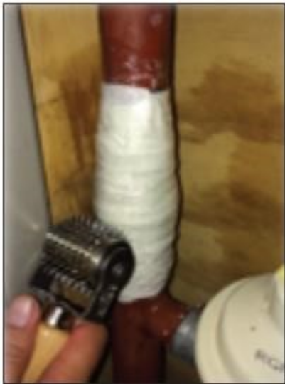
Foto 12 en 13 - Perforeren compressie folie en lekreparatie uitgevoerd
