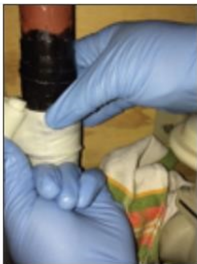
Foto 10 en 11 - Aanbrengen en aangebrachte Syntho-Glass band
