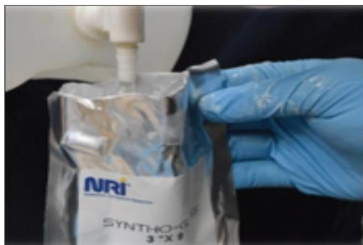
Foto 8 en 9 - Vullen en weken van syntho-Glass band
