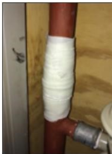
Foto 10 en 11 - Aanbrengen en aangebrachte Syntho-Glass band
