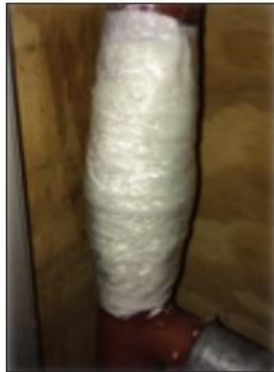
Foto 12 en 13 - Perforeren compressie folie en lekreparatie uitgevoerd
