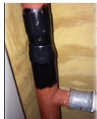
Foto 6 - Leiding met primer aangebracht
